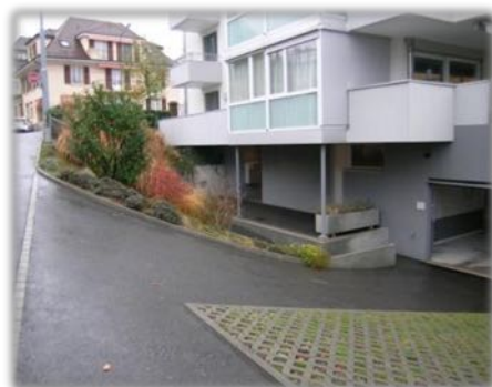
Pully : rampe d'accès à un immeuble beaucoup trop pentue malgré le permis de construire qui exigeait un accès adapté.
