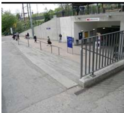
La Gare CFF de Nyon sera adaptée pour les personnes handicapées de la vue.
