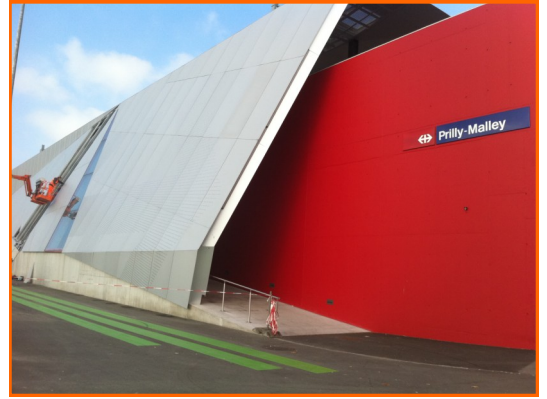
Gare de Prilly-Malley: Notre intervention date du 3 décembre 2007. Malheureusement nous n'avons pas pu obtenir les ascenseurs demandés, mais les espaces étant suffisants nous allons essayer de les faire installer.
