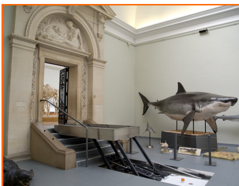
Palais de Rumine: L'entier du Musée de zoologie est enfin accessible par deux plateformes élévatoires qui s'intègrent dans le sol.
