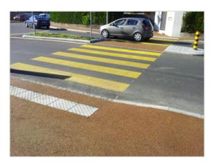
**Nyon :** arrêt de bus en construction avec les nouveaux profils de bordure. Abaissements de trottoir sans seuil de 25 mm, mais avec champ d'éveil à pastille. Cette conception n'est pas conforme aux normes en vigueur.
