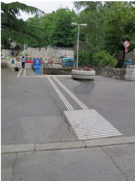
Passage sous-voie de la gare de Vevey ; lignes de guidage réalisées, comme préconisé.
