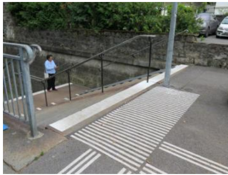
Passage sous-voie de la gare de Vevey ; lignes de guidage réalisées, comme préconisé.
