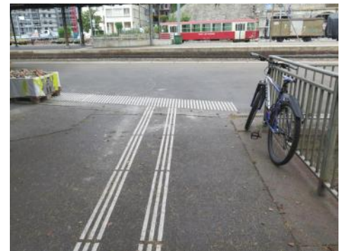
Passage sous-voie de la gare de Vevey ; lignes de guidage réalisées, comme préconisé.
