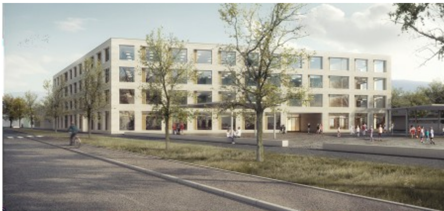
Collège secondaire des Rives à Yverdon.
