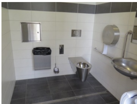
WC public à Avenches. La commune a fait réparer la barre rabattable vandalisée.
