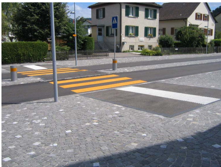
Figure 22 Ilot de protection dans la zone d'une voie polyvalente, Birmensdorf: La position du passage pour piétons est indiquée par des zones d'attention tactilo-visuelles
