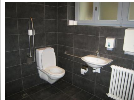
WC adapté dans la cour intérieure du château
