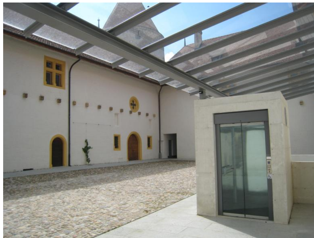
Cour intérieure du château
